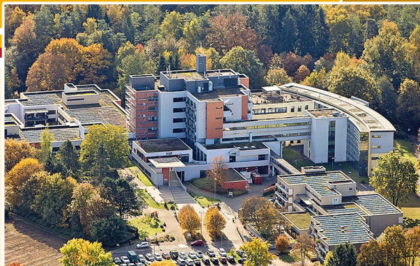
LUFTBILD GESAMTER KOMPLEX
