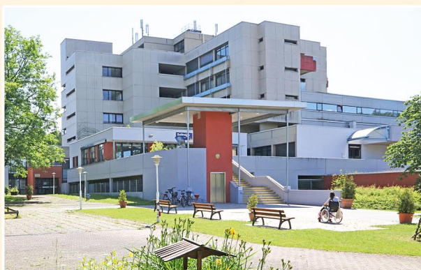
BLICK AUF DEN HAUPTINGANG
